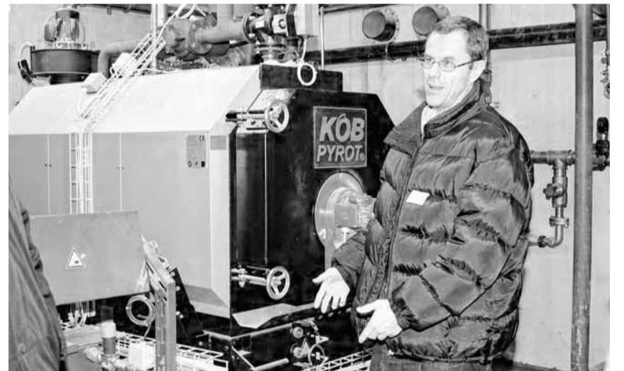
Regierungsrat Armin Hüppin begutachtet die Holzschnitzelheizung.
